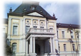
京都府庁舎旧本館
